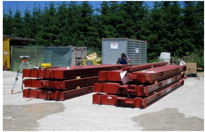
Kostengünstiger Transport durch Modulbauweise
