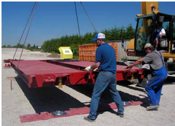
Einfacher Aufbau. Wartungs- und Reinigungszugang durch mittleren Spalt in gesamter Waagenlänge, die Wägezellen sind von oben zugänglich.
