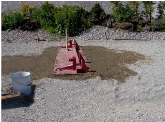
Einfache und schnelle Vorbereitung des Untergrundes (bauseitig)
