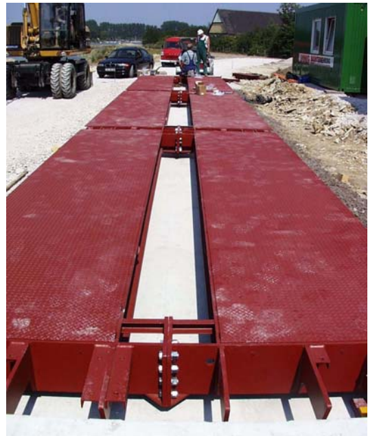
Montage MSW - Stahlbrücke ohne Abdeckplatten
