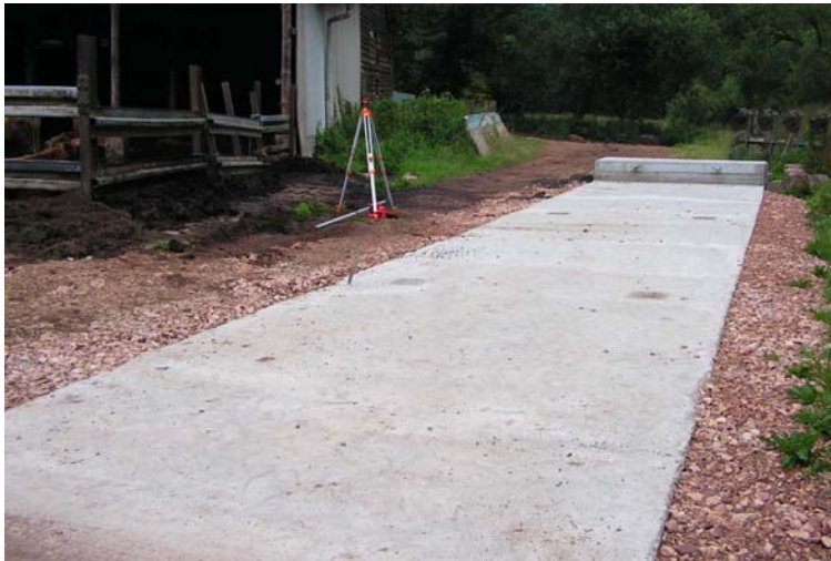
Bauseitige Auflagerbetonplatte
