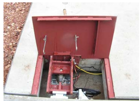
Einbau Wägezellen
